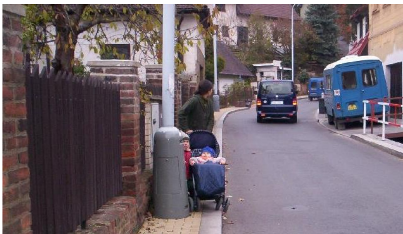
Obr. 4.5: Špatně umístěný sloup v chodníku zabraňující průjezdu (Praha – Podbaba) [23]
