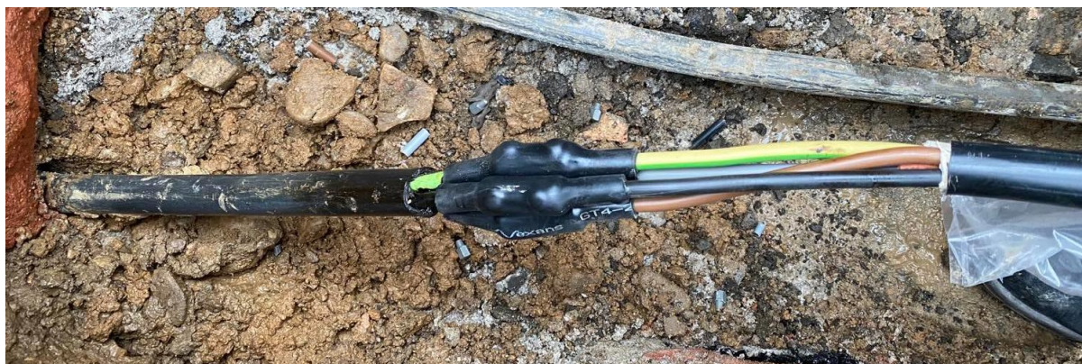
Obr. 2.27: Ukázka kabelové spojky před poslední vrstvou izolace
