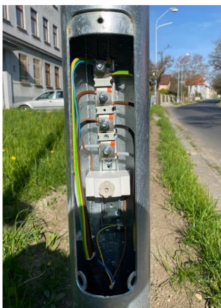
Obr. 4.9: Zapojení stožárové výzbroje pro průběžné vedení 2x CYKY-J 4x16
