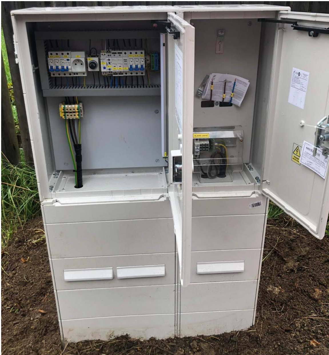
Obr. 2.28: Ukázka jednofázového RVO pro osvětlení kruhového objezdu v Mariánských Lázních
